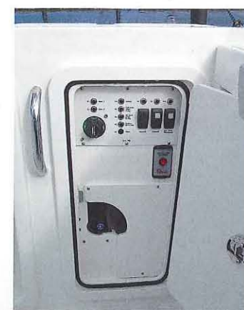
Perfekt zugänglich: E-Panel in der achterlichen Cockpitwand
